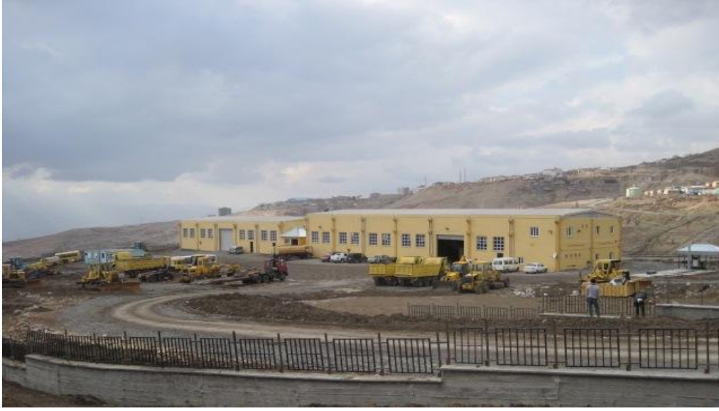
Şırnak İl Özel İdaresi Atölye ve Ambar Binası
