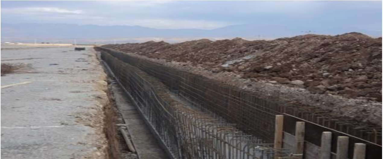
Tır Parkı Sahası Altyapı Çalışmaları
