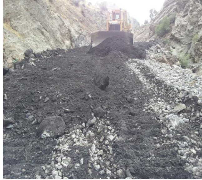
Yeni Yol Açma, Düzeltme ve Malzeme Serme
