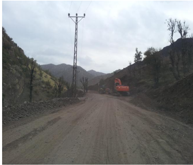
Yol genişletme ve sıkıştırma
