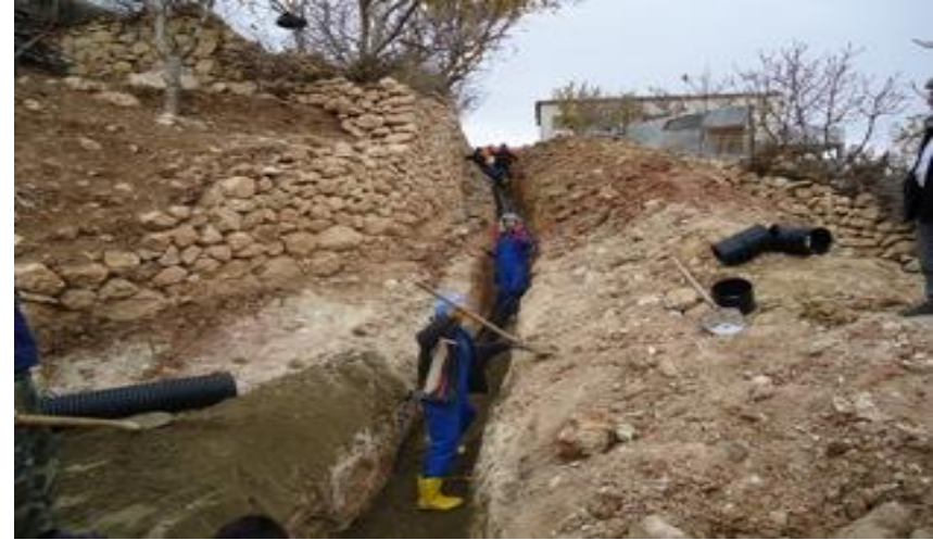
Yapılan Kanalizasyon Çalışmalarından Resimler
