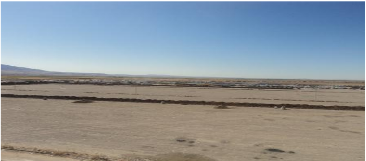
Tır Parkı Sahası Altyapı Çalışmaları
