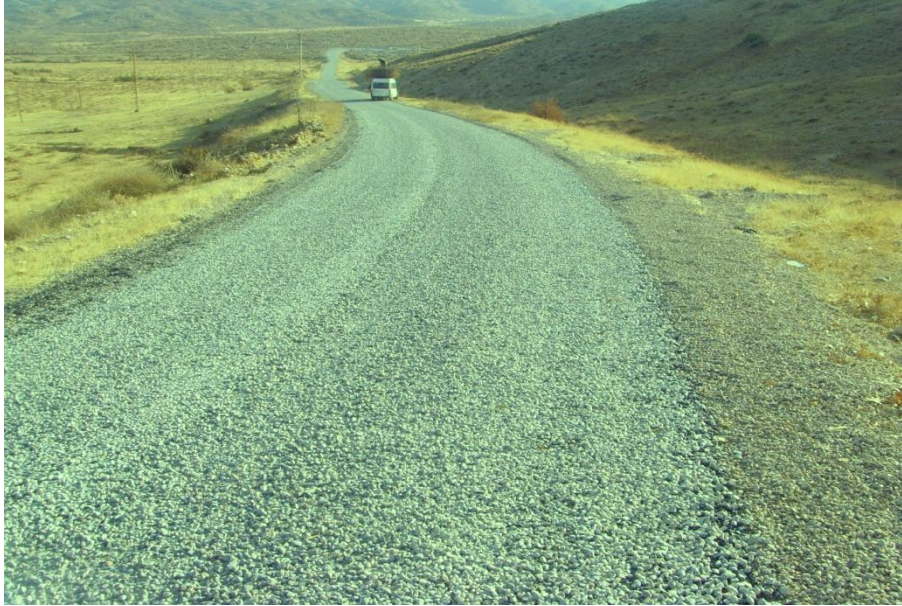
Asfalt Sathi Kaplama
