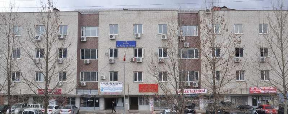
Şırnak İl Özel İdaresi Hizmet Binası
