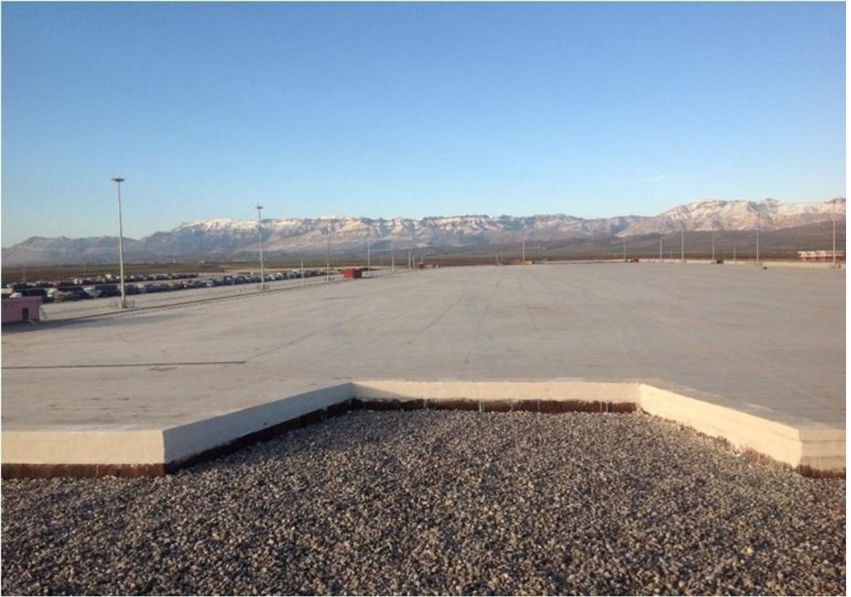
TIR PARKI (ZEMİN ÇALIŞMALARI)
