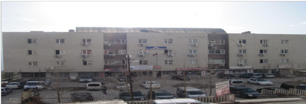
Şırnak İl Özel İdaresi Hizmet Binası
