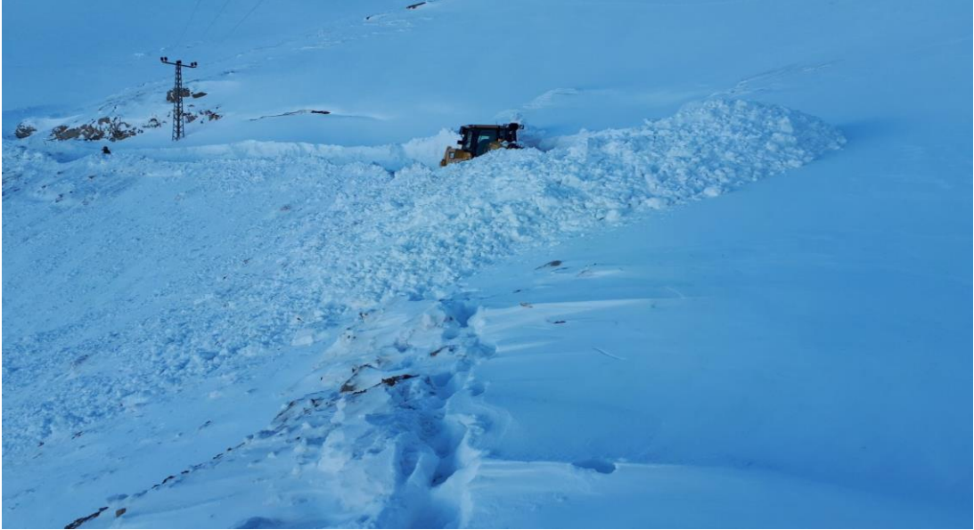
Uludere As.Üs.Bölgesi Yolu Dozer ile Kar Mücadelesi
