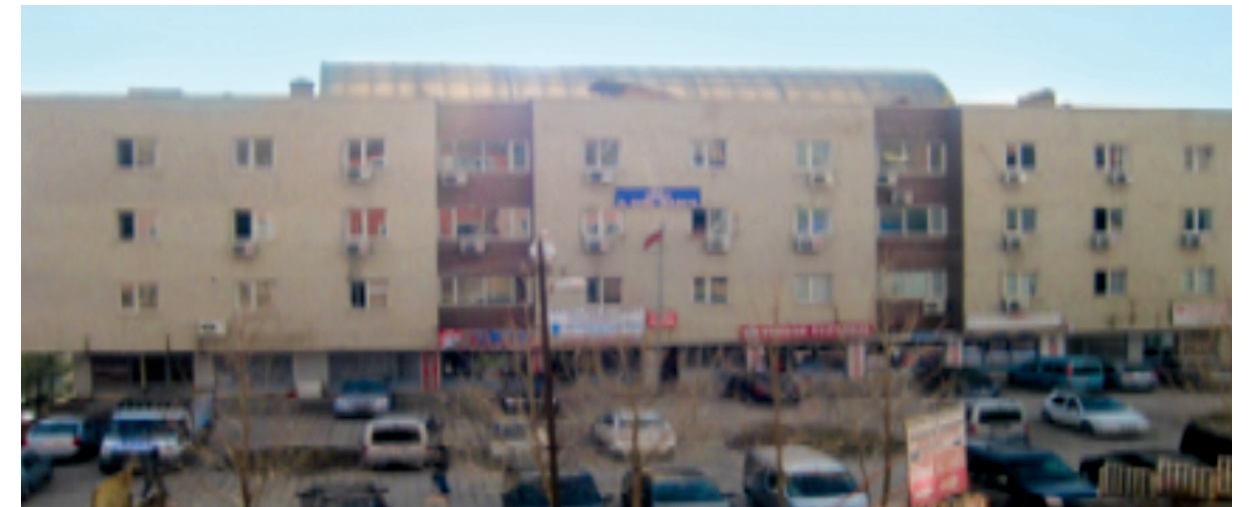
Şırnak İl Özel İdaresi Hizmet Binası
