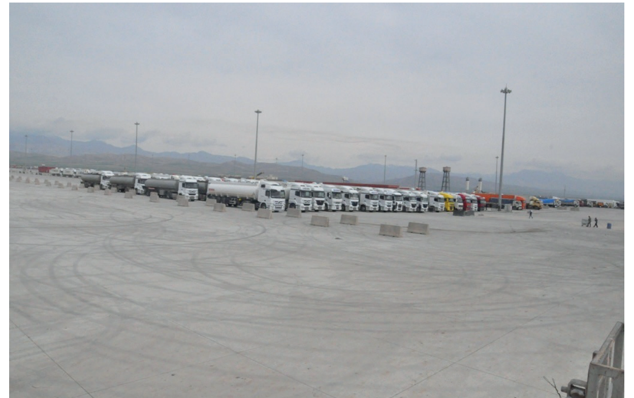
ŞİLOPİ TIR PARKI GENEL GÖRÜNÜM
